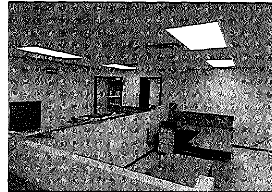
INSTALACION DE LAMPARA
