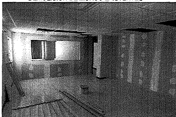
MURO DE TABLAROCA
